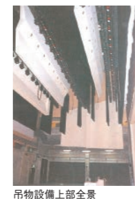
吊物設備上部全景
