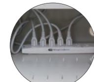
電源コンセント
