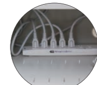
電源コンセント
