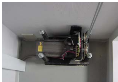
電動開閉装置モーター部（左右開閉タイプ）
