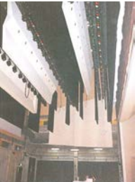
吊物設備上部全景
